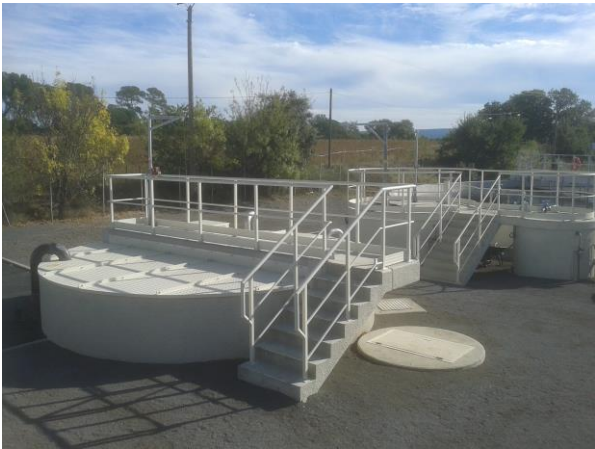
Station d'épuration de Saint André de Sangonis
