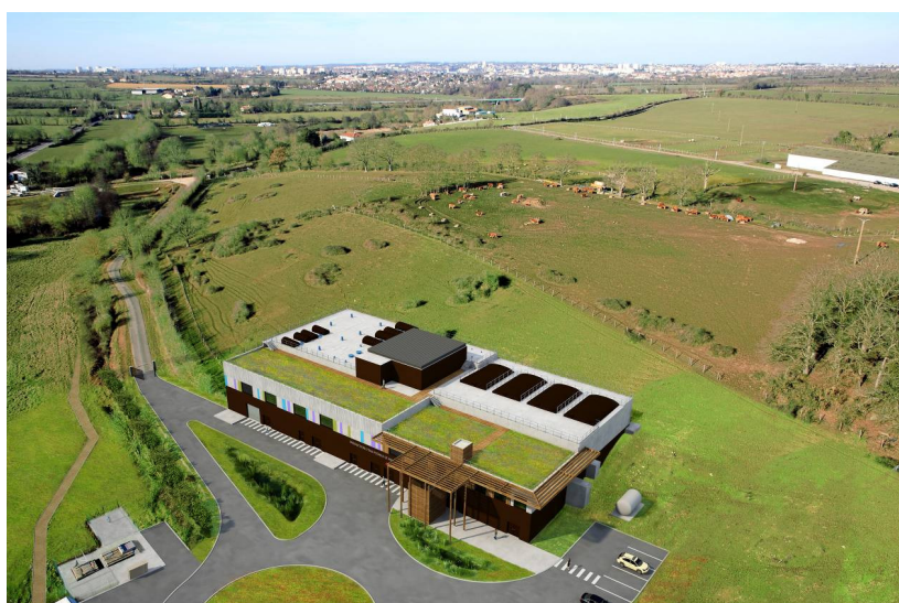
Station d'eau potable de CHOLET
