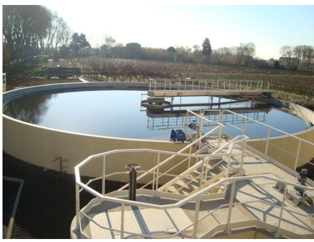
Station d'épuration de Bessan
