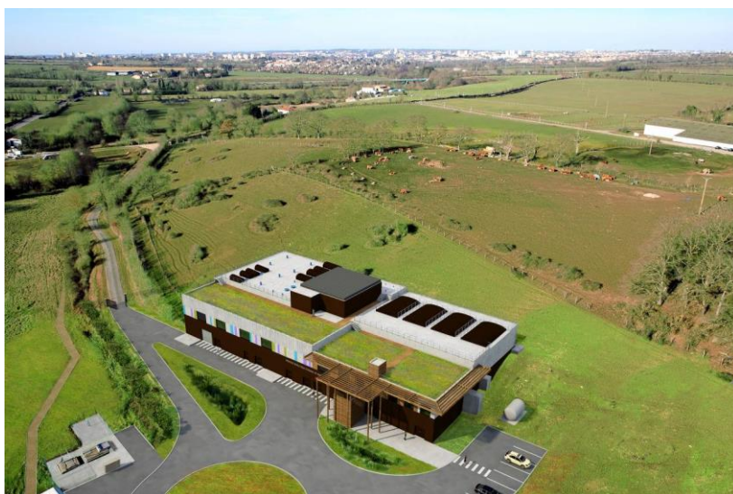
Station d'eau potable de CHOLET
